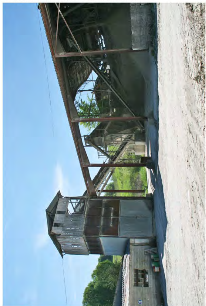
la tour où arrivent T8 (calcaire broyé) et T9 (ensacheuse, en bas) et le hangar qui abrite le stock (produit fini) de carbonate magnésien le stock de calcaire broyé
